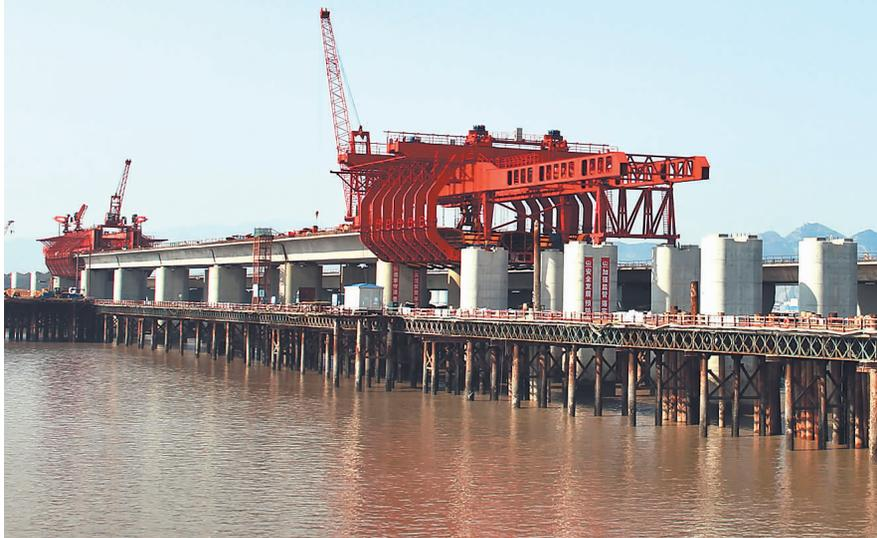
▲由二公司温州市域铁路S1线SG14标经理部承建的灵昆特大桥,设计为双幅四线铁路桥梁,全桥长3366.3米。由于桥梁左右幅箱梁最小间距仅20毫米,常规的单幅上行式和牛腿自走行式移动模架,无法满足施工要求。为此,经理部自主研发了50米双幅上承式移动模架。该移动模架可在原位同时施工左右幅箱梁,单跨箱梁施工完成后,移动模架整机过孔就位继续施工下一孔梁体;采用全液压系统控制移动模架落模、开合模,纵移过孔等施工工序,自动化程度高。双幅整体上承式移动模架技术属国内首创,填补了全国桥梁建设的技术空缺。截至3月9日,该移动模架已完成6跨箱梁,占计划总工程量31跨的19.4%,较快地推进了工程进度。(于涛 贡海斌 摄)
