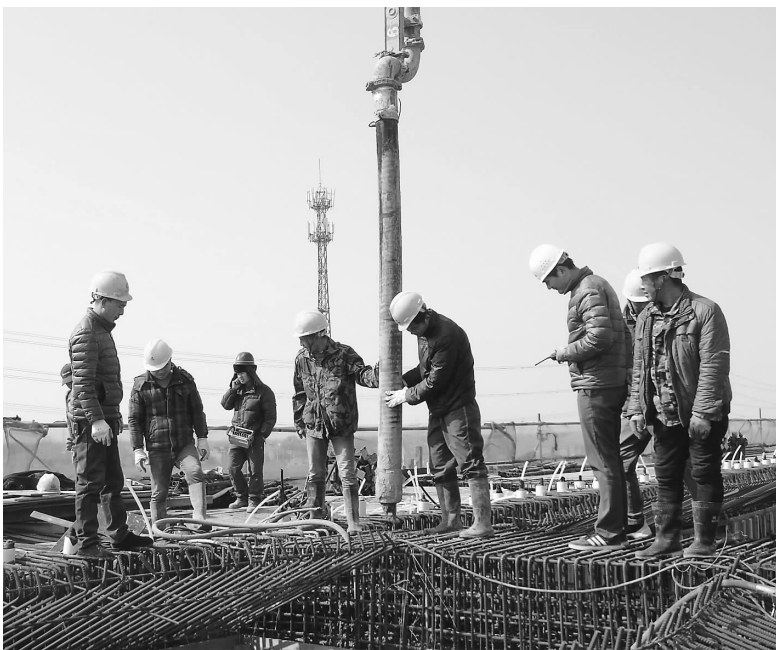
▲3月2日凌晨,历经 15 个小时连续奋战,连(云港)盐(城)铁路经理部五分部(上海公司)跨既有道路连续梁底板、腹板混凝土浇注施工顺利完成,累计浇注混凝土 750 立方米。本次浇注施工的连续梁位于盐河特大桥第 488~491 号墩间,横跨连云港市灌云县杨集镇既有公路,具有施工工艺复杂、混凝土浇筑要求高、参与施工人员多等特点。(宋中海 吴天运 摄)
