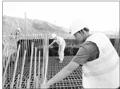
▲肋板钢筋绑扎复核
