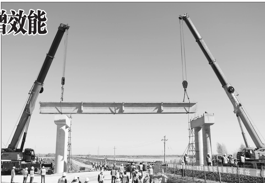
▲首孔箱梁架设
