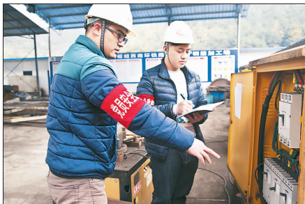
↑党员安全监督员在施工现场对工地配电箱进行例行检查。
