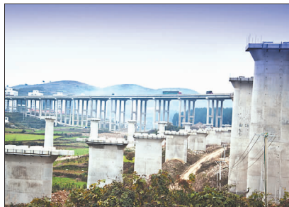
↑正在施工中的贵阳枢纽西南环铁路正线及马寨联络线。
