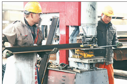
↑作业工人齐心协力对桥梁护栏构件进行钻孔。
