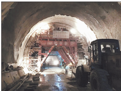
↑关堰隧道二衬立模加固,确保顺利浇注。
