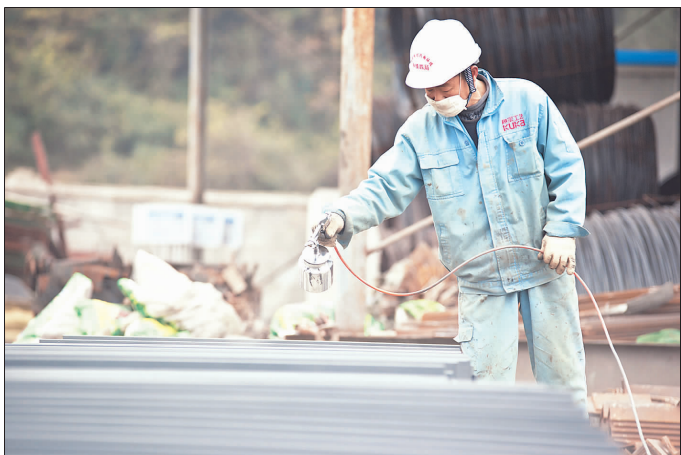
↑作业工人对桥梁护栏使用的构件进行防锈喷漆。
