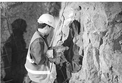
▲暗挖打钻炮眼
