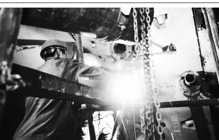
▲4月11日,二公司常州地铁经理部施工人员在旅游学校站进行冷冻管道安装。经理部领导靠前指挥,技术人员投身一线,现场安全员24小时安全巡视,发现问题定人限时整改,保证了各工序有序衔接。(姜永祥 高炼 摄)
