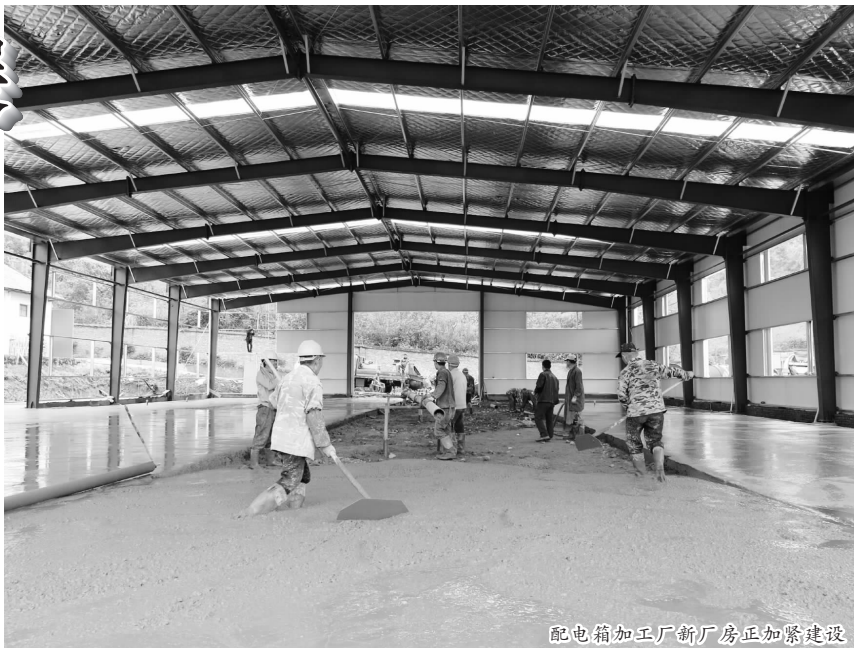
配电箱加工厂新厂房正加紧建设
