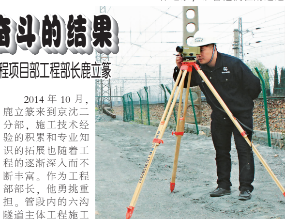
▲鹿立篆在施工现场进行测量
